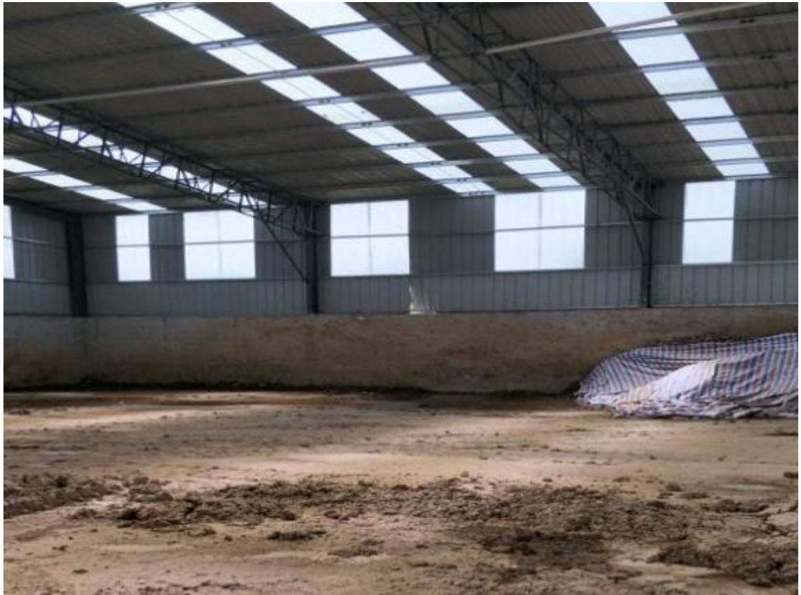
图 4-4 现有一般固废堆场
