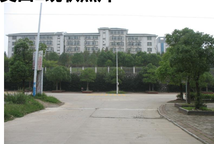
交口4现状照片
