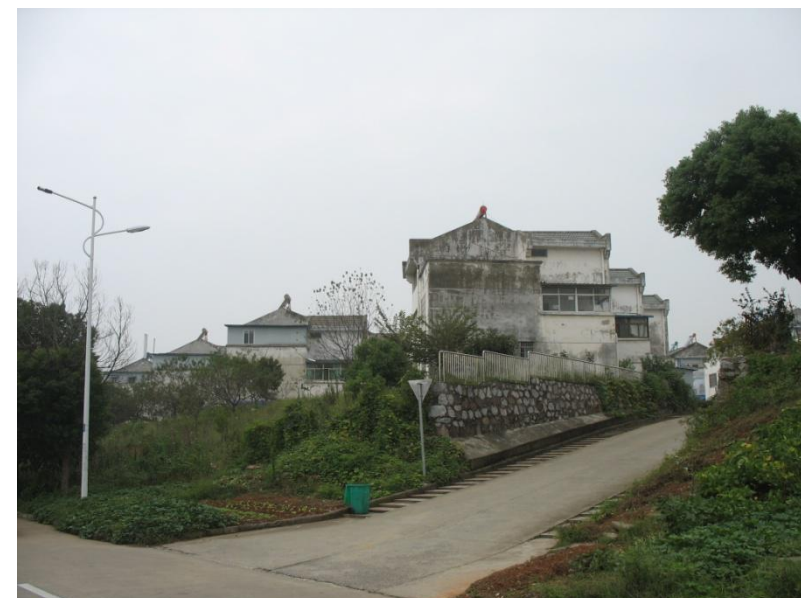
现状居住小区
