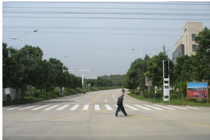
交口1现状照片
